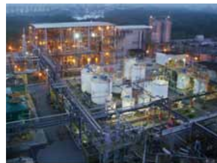
Unigel: fábrica de PS ajustada para produzir ABS.
