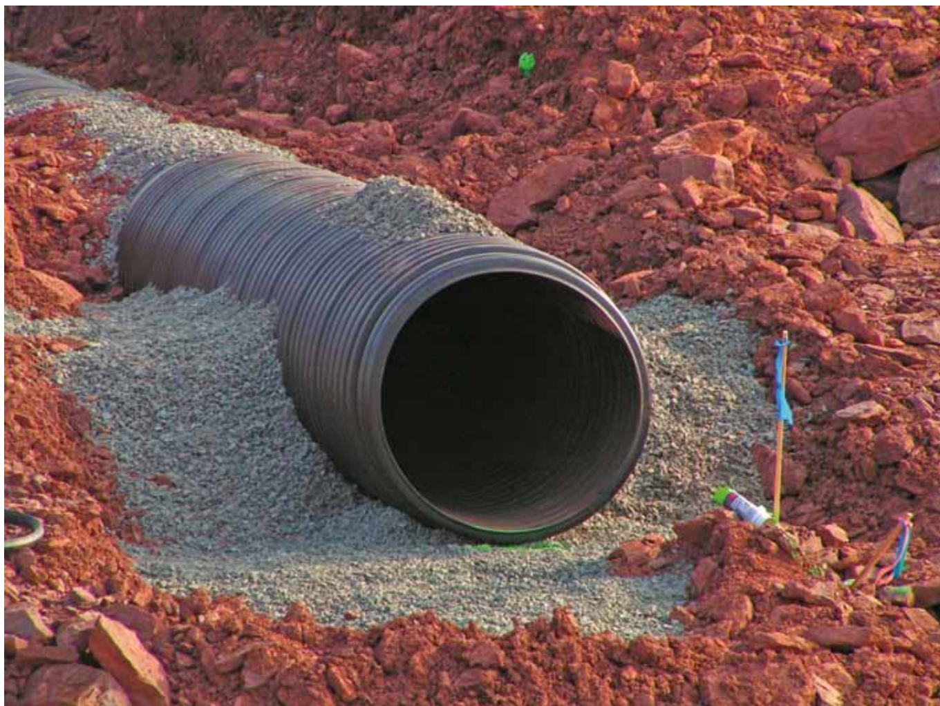
Tubos de infraestrutura: burocracia ainda dificulta a liberação de recursos.
