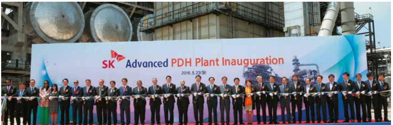
Propano: inauguração de planta sul-coreana de dehidrogenação.
