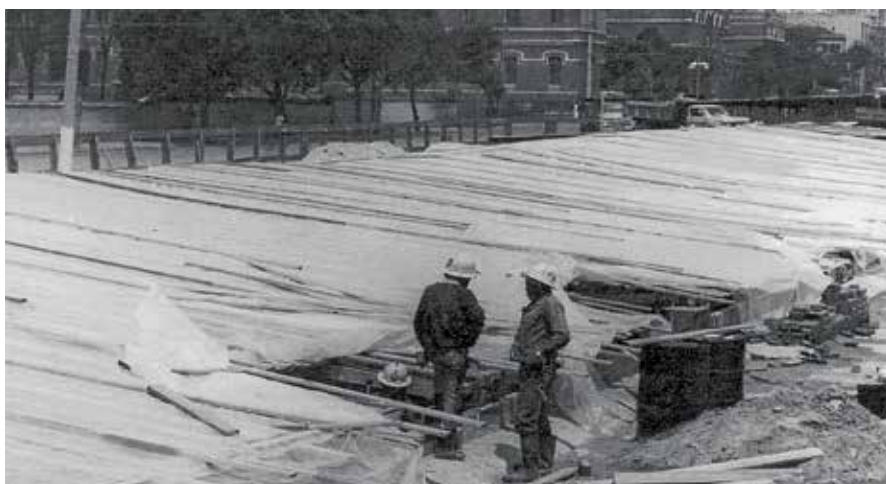
Lona Terreiro: impermeabilização das obras do metrô paulistano.
