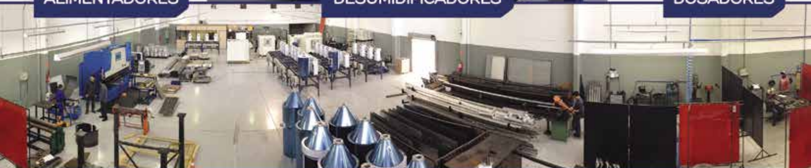
SECADORES • CENTRAL DE DOSAGEM • CENTRAL DE ALIMENTAÇÃO • CENTRAL DE DESUMIDIFICAÇÃO
