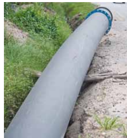
Tubos de infraestrutura: consumo retido pela gestão dos programas de governo.
