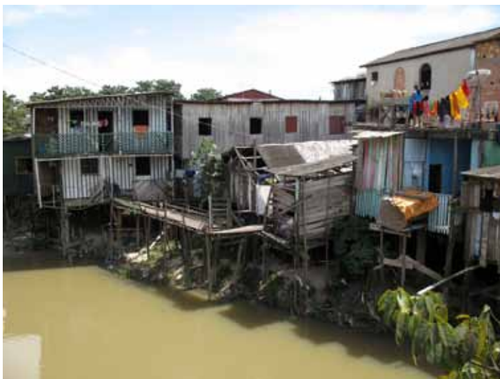
Déficit de água e esgoto: contraste com demanda pífia de tubos para infraestrutura.
