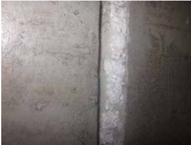
Styropor: obras como juntas de dilatação em quatro estádios.
